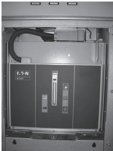
图8 断路器手车在试验位置
