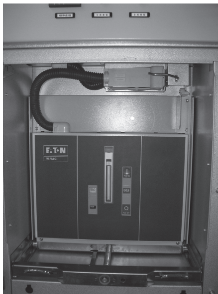
图9 断路器手车在工作位置
