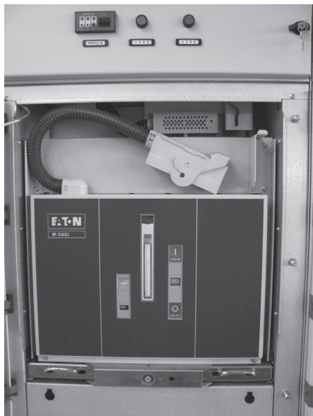
图7 断路器手车在断开位置
